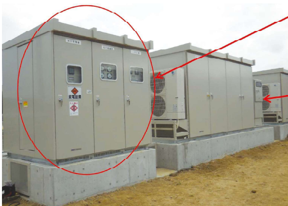
高圧連系・受配電盤の設置例
