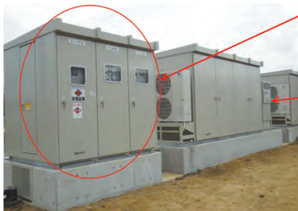
高圧連系・受配電盤の設置例
